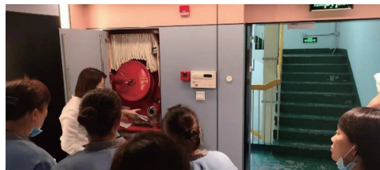
掌握消防栓使用方法
